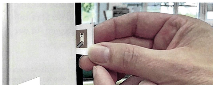
Einbau des e-Chip in den Fensterflügel oberhalb des Griffes.
